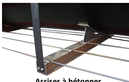
Assises à bétonner
